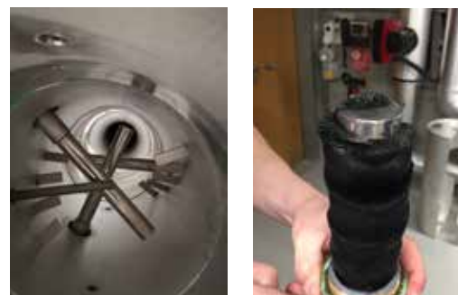
Innenansicht einer großen Version des Ferro-Cleaner. Beispiel für die Effizienz des Ferro-Cleaner
