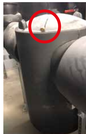
Unterschied zwischen den von den Wettbewerbern verwendeten Magneten (oben auf dem Abscheider) und dem Zeparo
